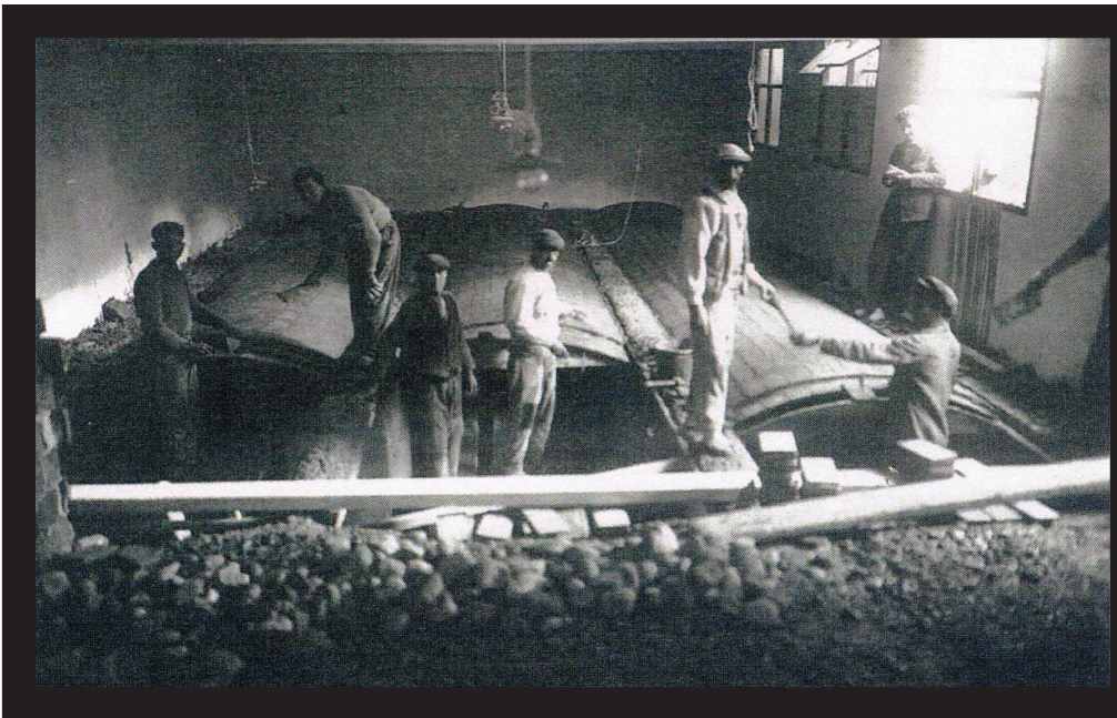
Construcció d'un refugi antiaeri a Tarragona.
